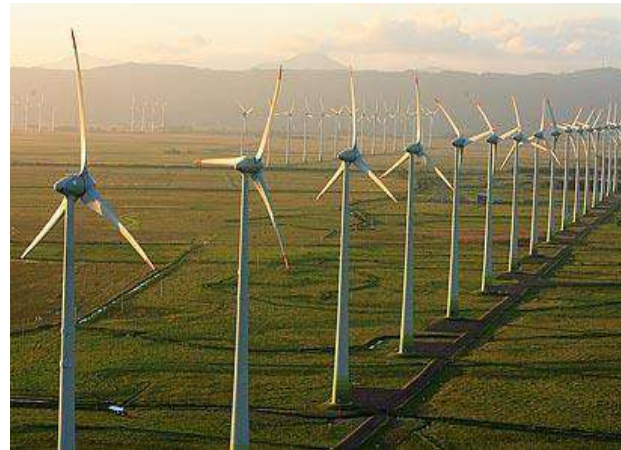
Parque Eólico de Osório: instalado no município gaúcho de Osório, é o segundo maior centro de geração de energia eólica no Brasil (em 2011).
